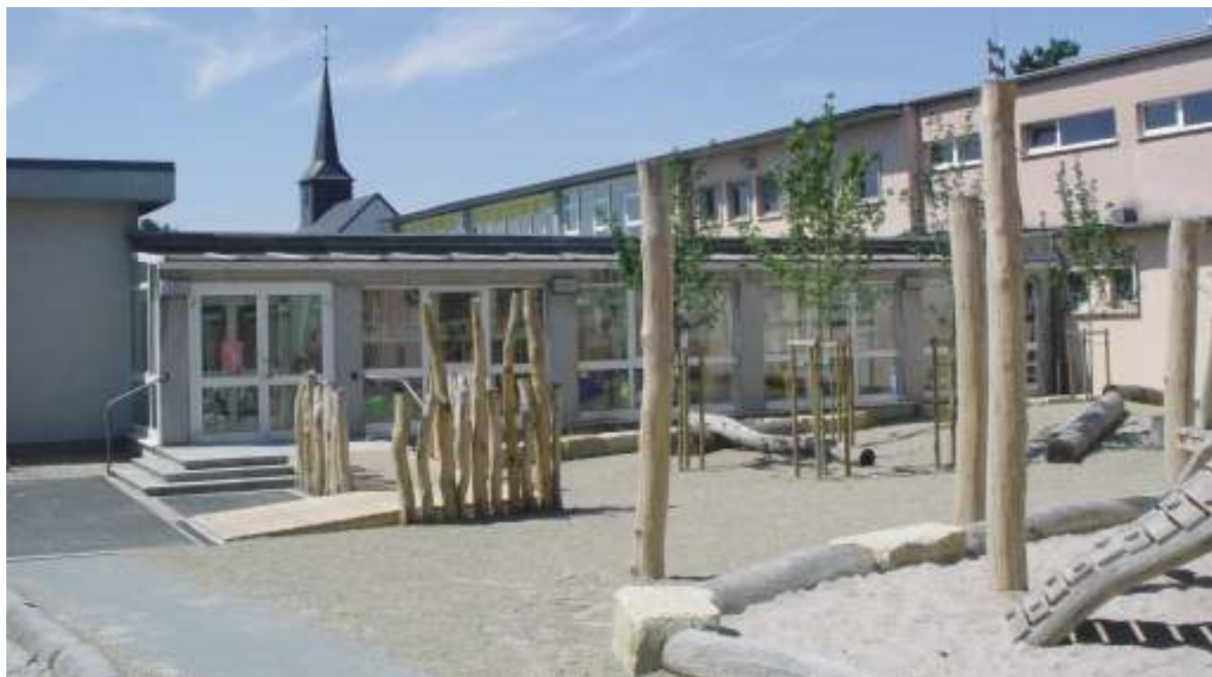
Cour d'école préscolaire à Pontpierre
