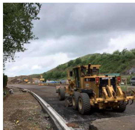
Straßenbauarbeiten im Juni 2017
