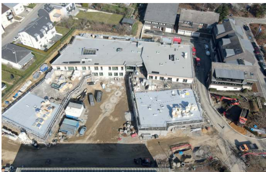
Chantier nouvelle Maison Relais
