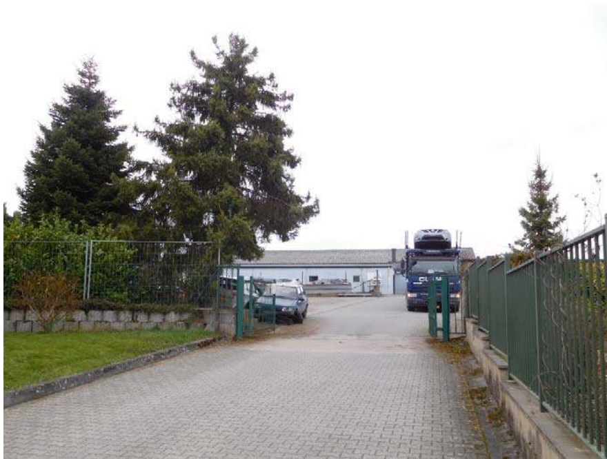
Bereits genutzte Fläche
